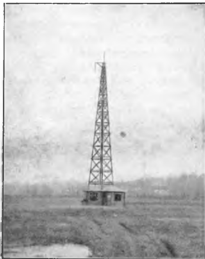
Een radio-baken voor vliegtuigen, ingericht door het Bureau of Standards te Colledge Park, Md.
